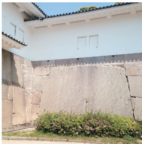
大阪城の石垣(巨石) 大手二番石
