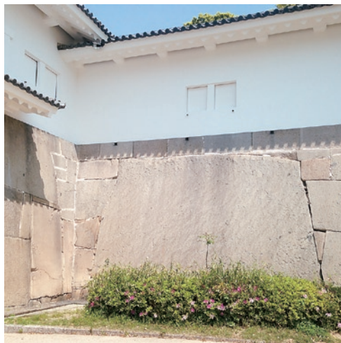
大阪城の石垣(巨石) 大手二番石
