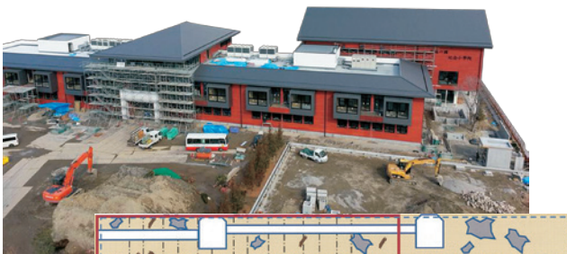
(断面図) 国の説明図 9.9mの杭部分は天然の堆積物層で、廃材などはありません
