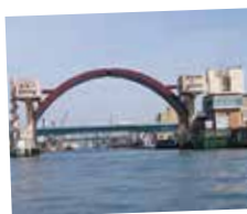
安治川水門 (大阪府HPより)
